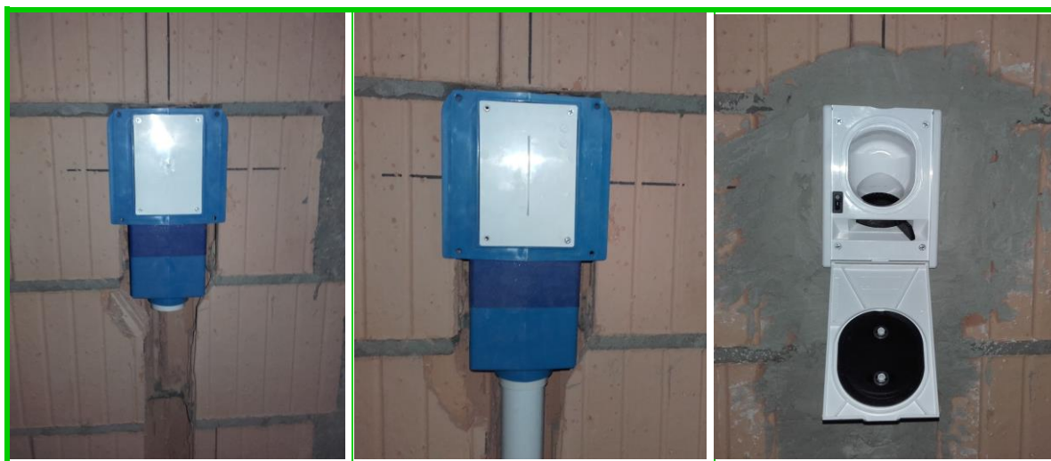
Poprawny montaż elementów zestawu wraz z podłączeniem instalacji
