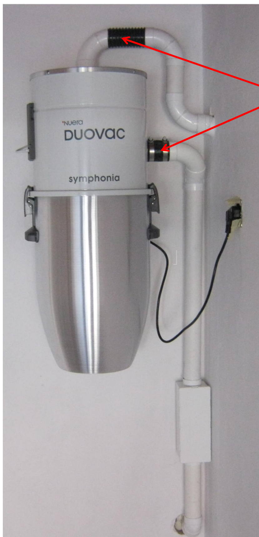
Rys. 5. Jednostka centralna z tłumikiem zamontowanym w dół
