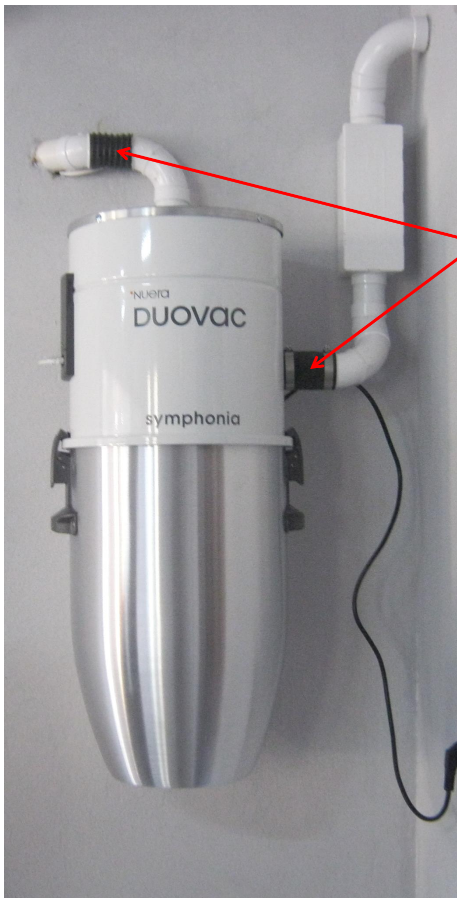
Rys. 6. Jednostka centralna z tłumikiem zamontowanym w górę
